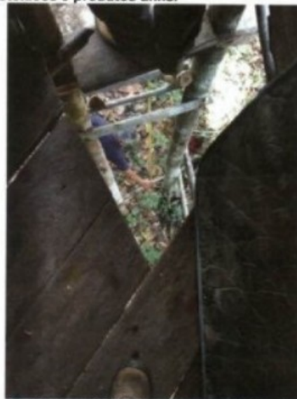
Figura 10: vão que havia entre a escada de acesso e o assoalho do barraco de lona levantado na árvore.
