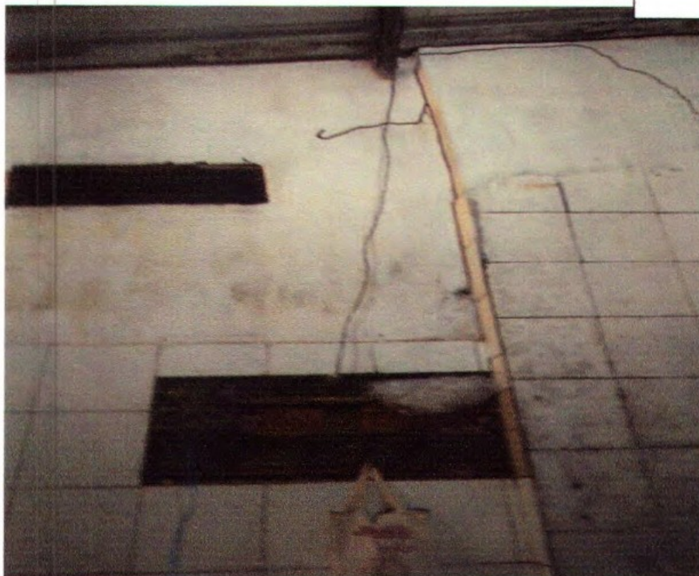
Instalações elétricas improvisadas, sem aterramento e com uso de dispositivos fora do padrão das normas técnicas.
