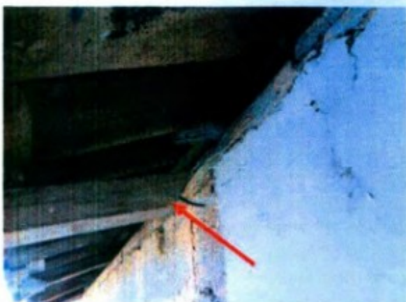
Figura 12 - A imagem mostra uma emenda de caibro solta sobre a entrada da casa. Fotografia de 12/09/2017.
