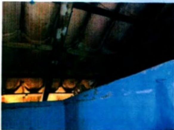
Figura 14 - Observar as frestas entre parede e telhado na cozinha da edificação. Fotografia de 12/09/2017.
