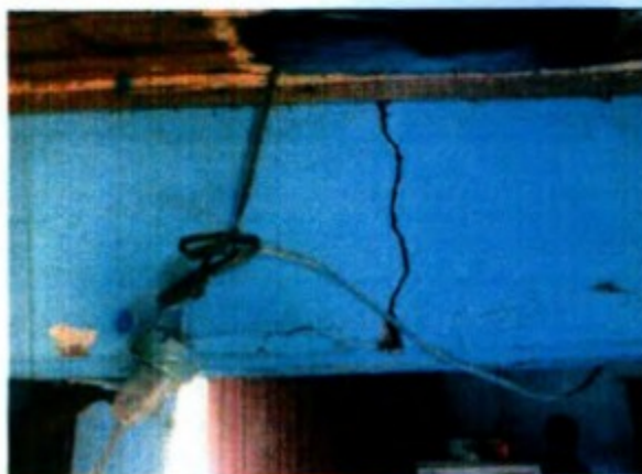
Figura 8 - Rachadura sobre batente da porta do dormitório dos homens. Fotografia de 12/09/2017.
