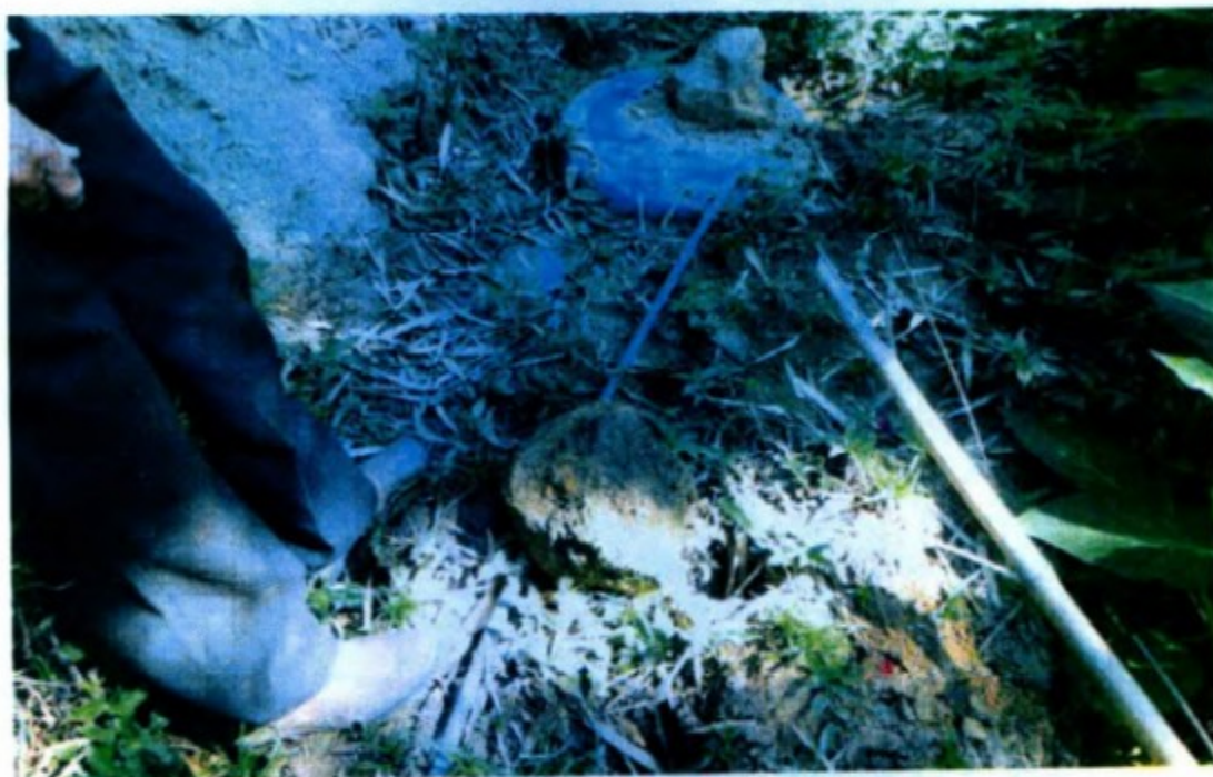
Figura 18 - Nesta figura pode-se observar com mais detalhes o fundo do barril de plástico enterrado e a mangueira que leva a água até a caixa d'água do alojamento de trabalhadores. Fotografia de 13/09/2017.
