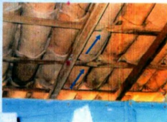
Figura 11 - Aqui, no telhado do quarto das mulheres, as setas indicam descontinuidade das ripas do madeiramento. Fotografia de 12/09/2017.
