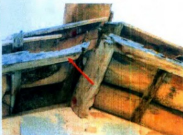
Figura 13 - A imagem mostra a empena do telhado solta e destruída por cupins. Fotografia de 12/09/2017.
