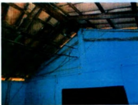
Figura 36 - Condutores passando sobre as cabeças dos trabalhadores na cozinha da edificação. Fotografia de 12/09/2017.
