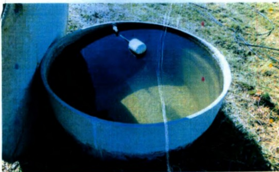
Figura 21 - A caixa d'água do alojamento destampada, mostrando suas paredes interiores cobertas por lodo. Fotografia de 13/09/2017.
