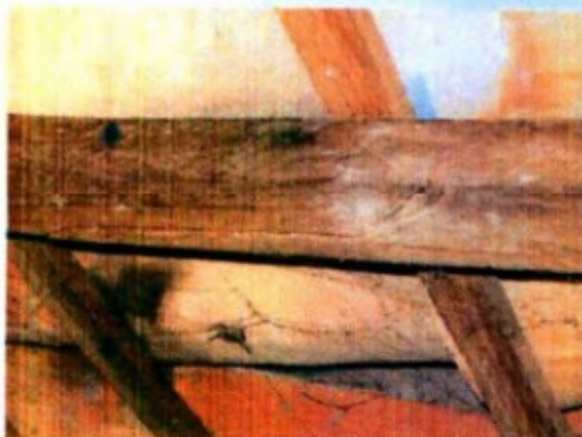
Figura 10 - Aqui, também no telhado sobre a cozinha, pode-se observar rachadura em caibro. Fotografia de 12/09/2017.
