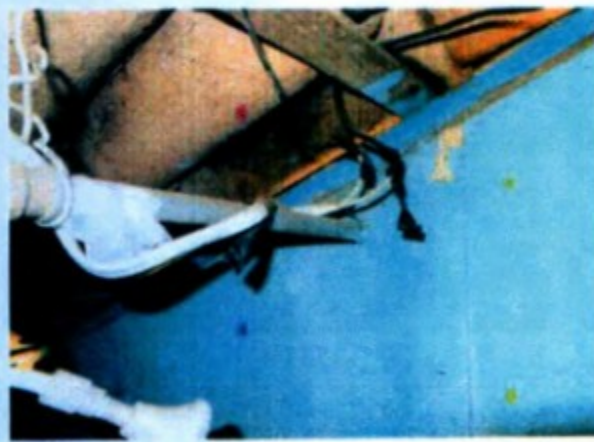
Figura 37 - Observar isolamento dos condutores do chuveiro se soltando. Fotografia de 12/09/2017.
