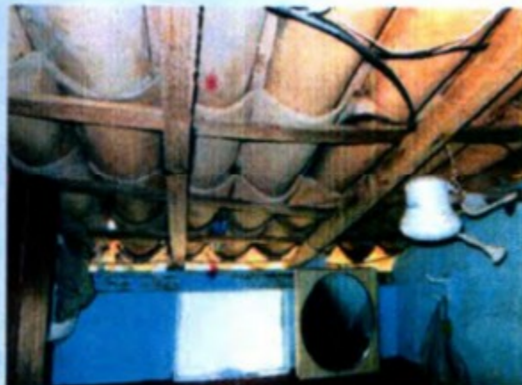
Figura 15 - Observar as frestas entre parede e telhado no banheiro da edificação. Fotografia de 12/09/2017.
