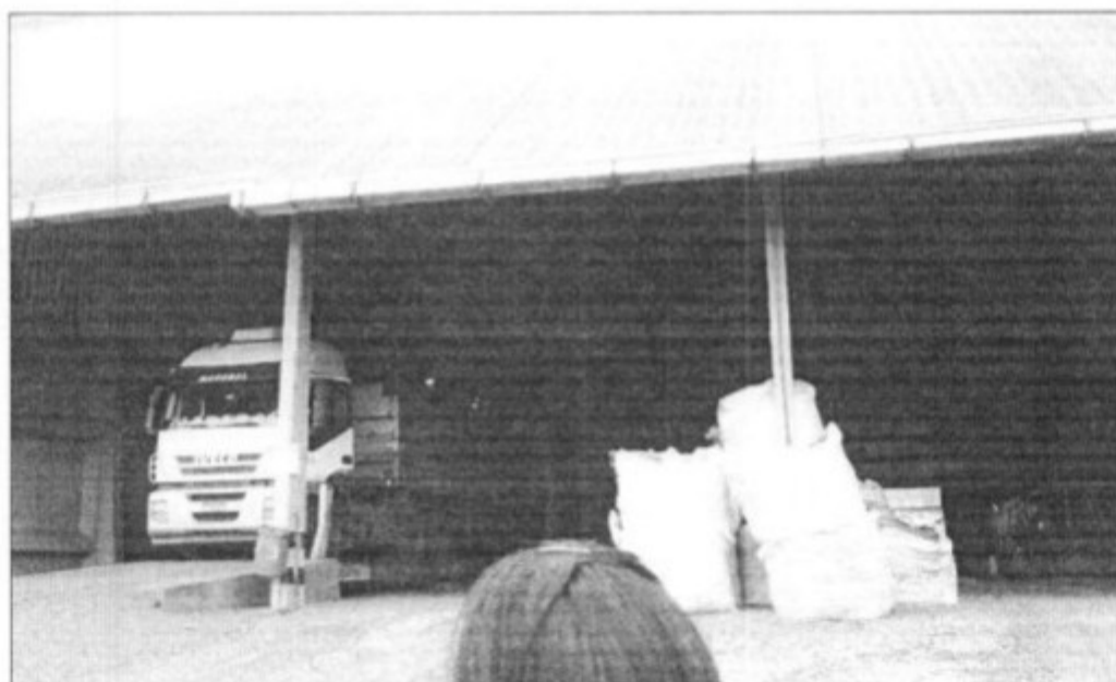
Figura 4 - Vista frontal do local de abastecimento/desabastecimento da carga de grãos. Armazém 1
