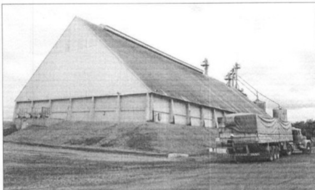
Figura 3 - Vista externa de um dos armazéns. Armazém 1.
