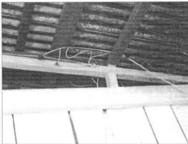
Figura 12 - Fiação exposta
