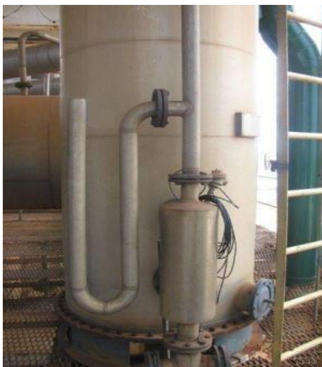
Figura 10 – Proteção contra vácuo utilizando um sifão
