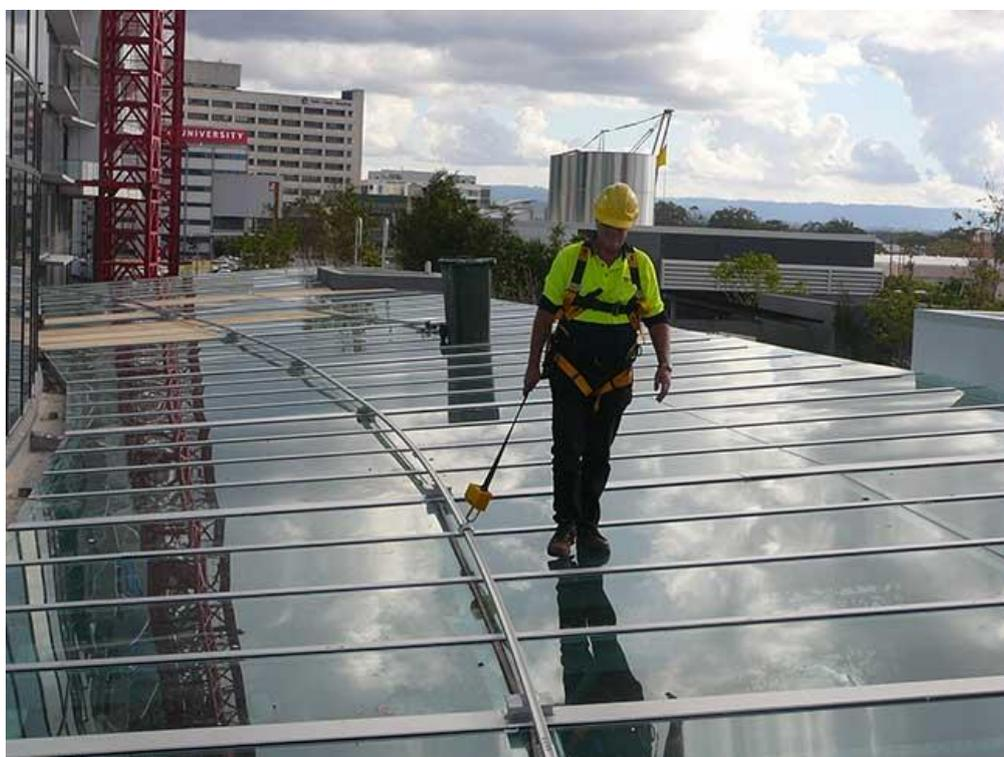
**Figura 24. Exemplo de Sistema baseado em linha de ancoragem horizontal rígida. Fonte: CAI Safety Systems**
