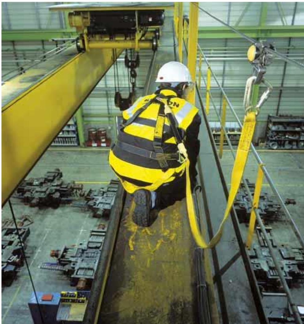
**Figura 43 Tipo C – Exemplo de linha de ancoragem horizontal flexível**
