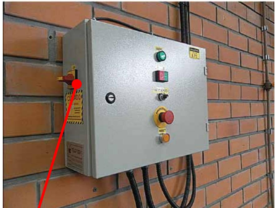
Chave seccionadora que permite o bloqueio
