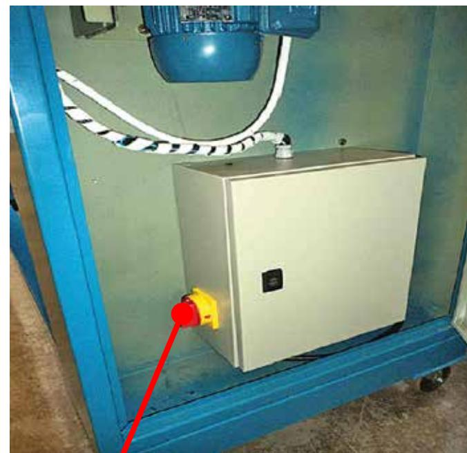
Chave seccionadora que permite o bloqueio
