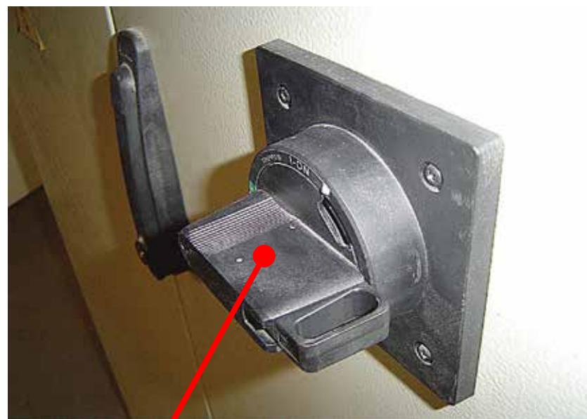
Chave seccionadora que permite o bloqueio
