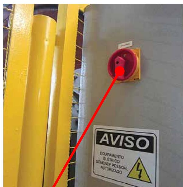
Chave seccionadora que permite o bloqueio
