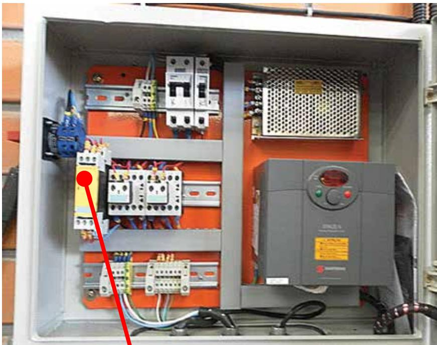
Relé de emergência de monitoramento do cabo de emergência
