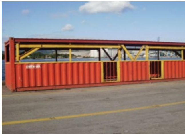
Figura 1.2. Gaiola operacional, Santos/SP, 2014. (Fonte: Libra Terminais/SP).
