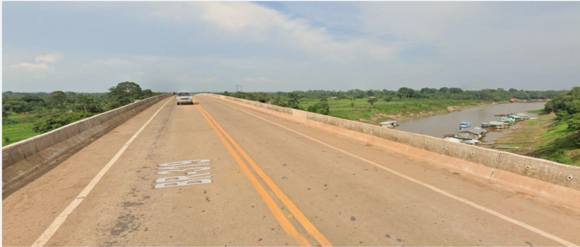
Ponte sobre o Rio Aracá, na BR-319 (Reprodução/Google Street View)
