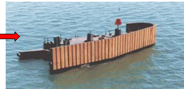
Sistema flutuante de proteção de pilares de pontes
