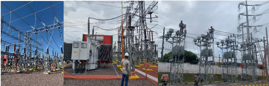
Obras de Ampliação da Subestação Mutirão 138/13,8 kV
