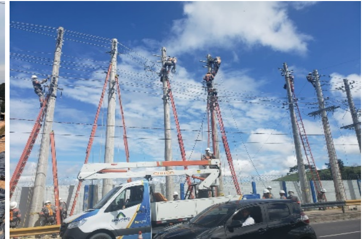
Obras de construção de novos circuitos alimentadores em 13.8 kV
