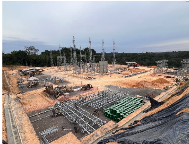
Obras em andamento na Subestação Distrito III
