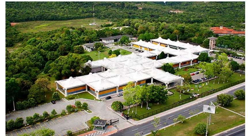
Figura 7 – Vista aérea da SUFRAMA.
