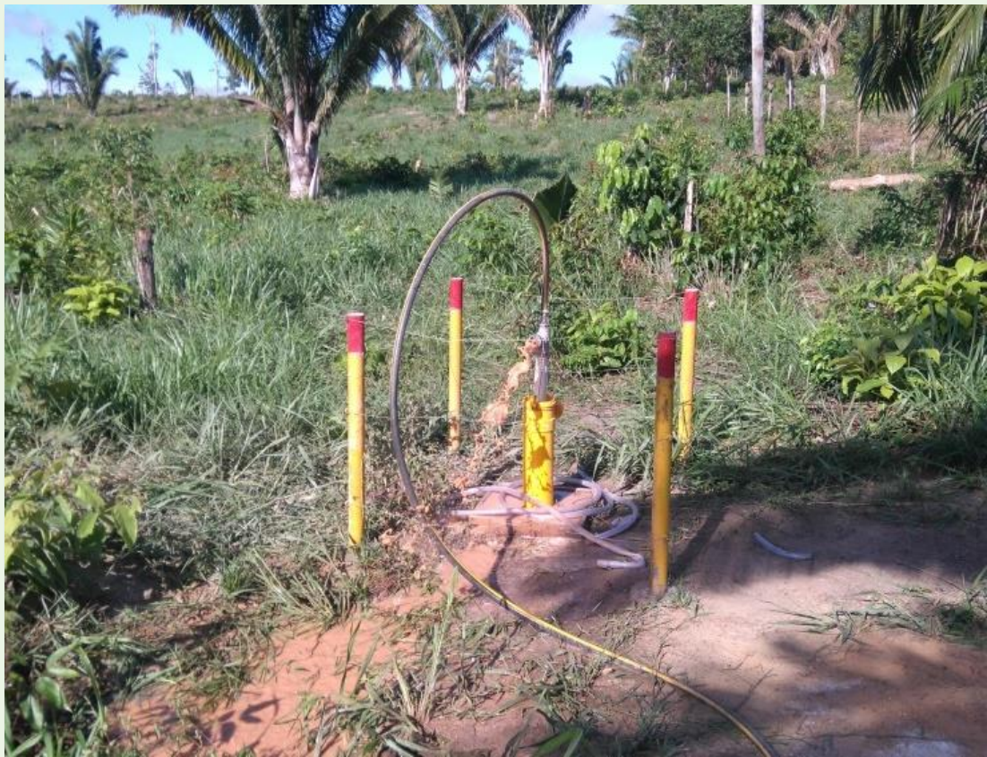
Desenvolvimento dos poços de monitoramento
