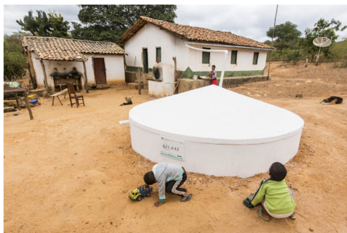
Figura 2: Cisterna típica construída pelo PC1A
