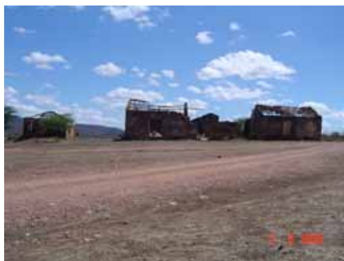
Figura 74 - Ruínas da fábrica de beneficiamento do caroá (Ponto 207 - UTM/SAD 69 - 0510948 - 9094058). Foto: Victor Uchôa Ferreira da Silva.
