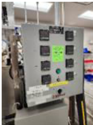
Figura 1 – Imagem do equipamento unidade de controle de temperatura para encapsuladora
