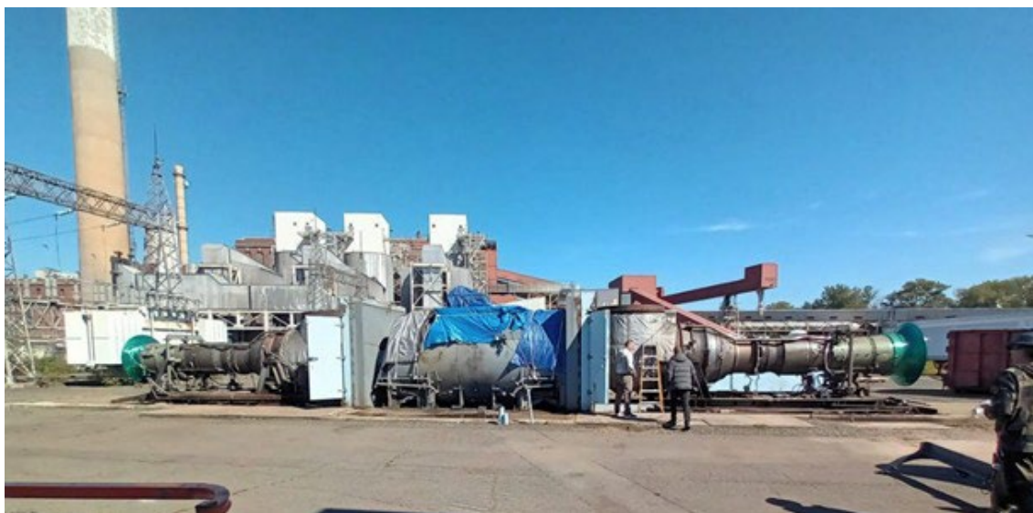
Grupo Eletrogêneo – Turbina "B" a esquerda, Gerador ao centro e Turbina "A" a direita
