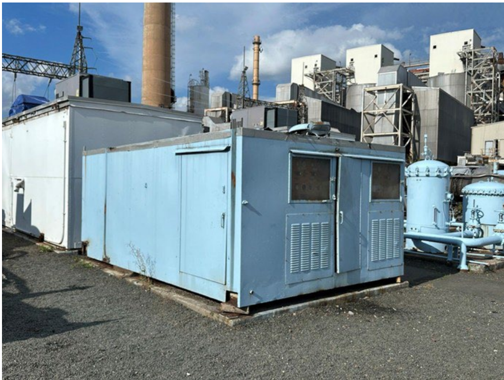
Sistema de Ar de Partida ou Casa dos Compressores
