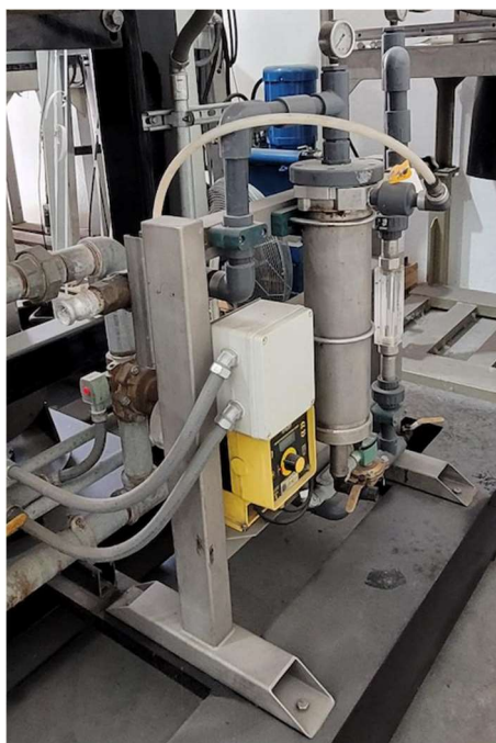
4.6 - Sistema de Mistura e Dosagem de Polímero em Emulsão automatizado, Modelo IP22316, Marca Centrisys.
