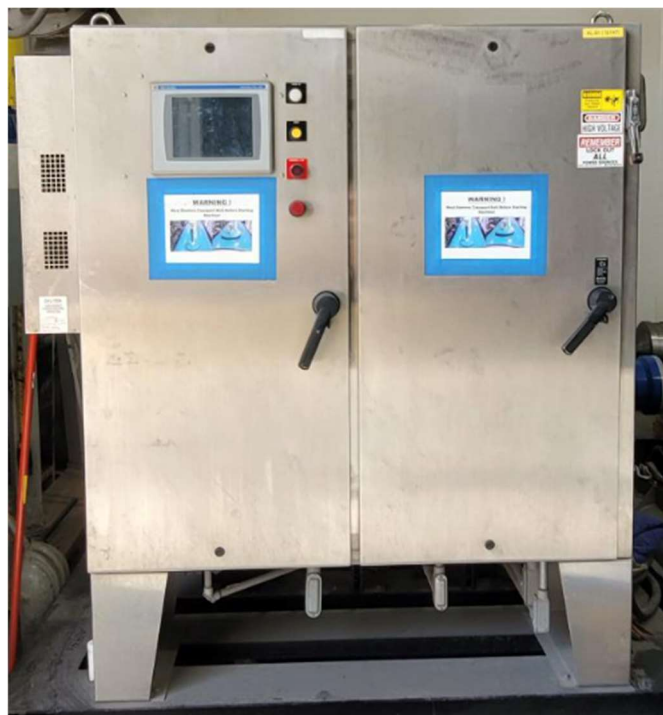
4.5 - Painel de Controle com sistema de Automação e PLC Allen Bradley e Inversores em Inox 304.
