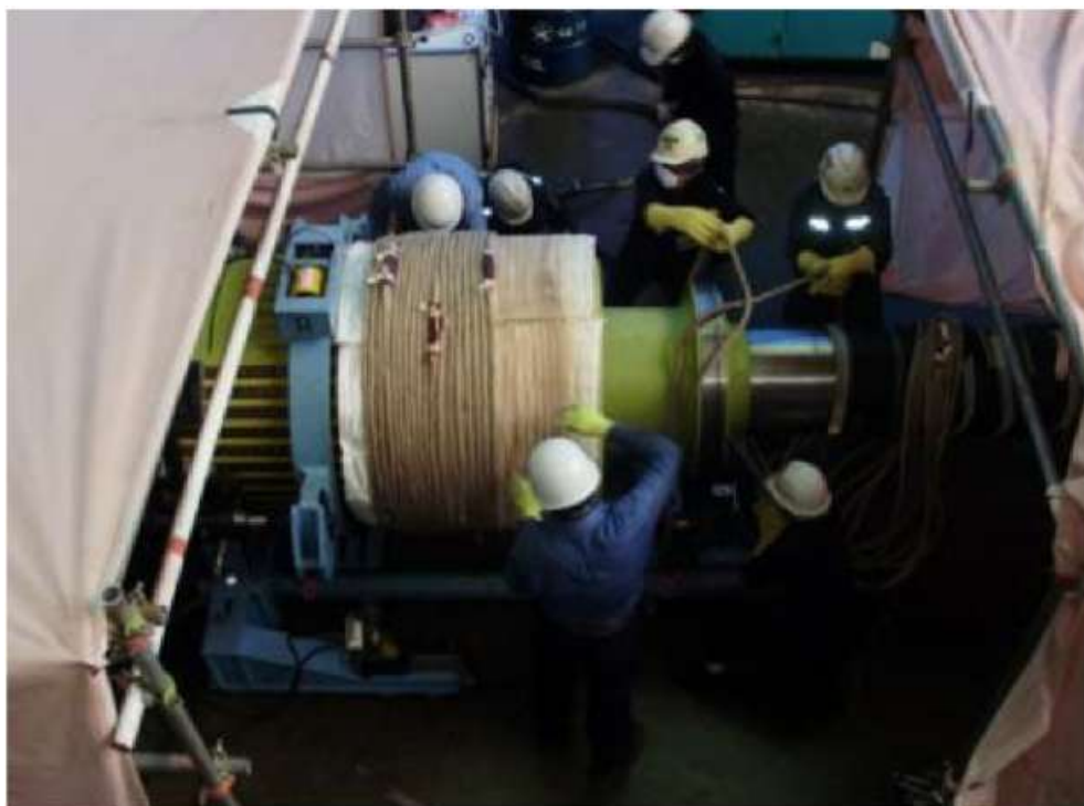
Cabo de Indução enrolados no Anel Retentor do Gerador
