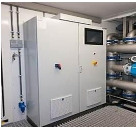
Figura 4 - Painel elétrico de controle
