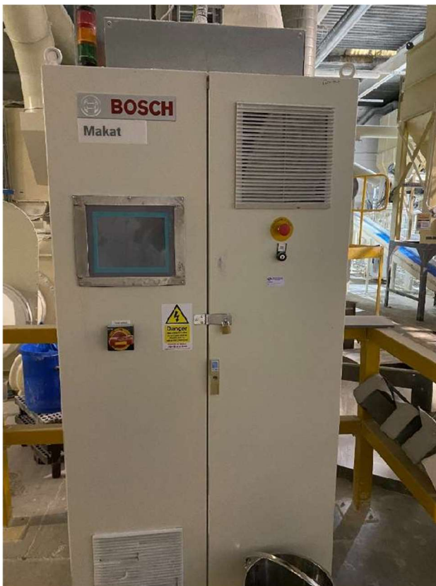
(01) um painel elétrico com CLP e IHM
