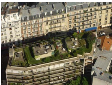
Figura 6 - Exemplo de Telhado Verde Intensivo
