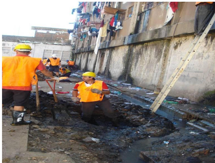
Reforma das instalações sanitárias
