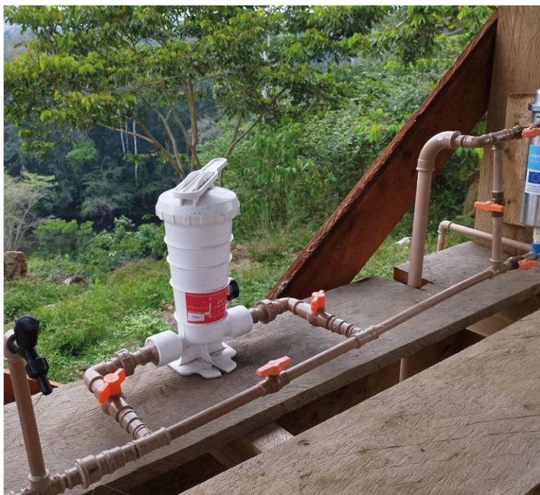
Clorador e torneira de monitoramento de cloro instalado na comunidade.
