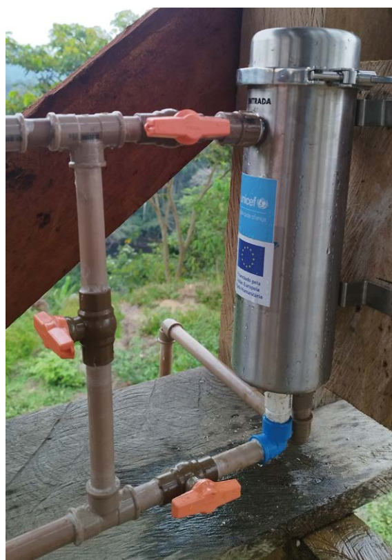
Filtro de membrana e registros na posição de filtração
