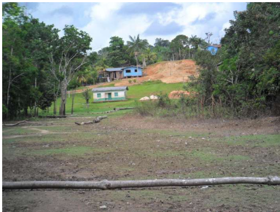
Foto 3. Linha da Adutora instalada.
