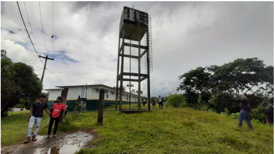
Foto 5. Vista do RE existente do SAA da Aldeia.
