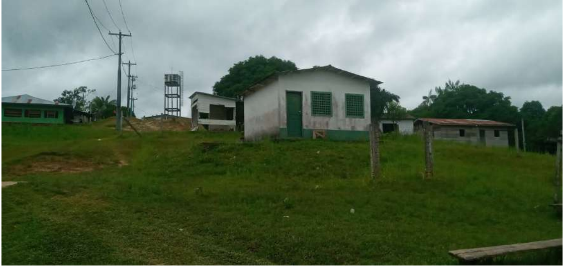
Foto 4. Vista dos Elementos estruturais do Sistema de Abastecimento de Água - SAA
