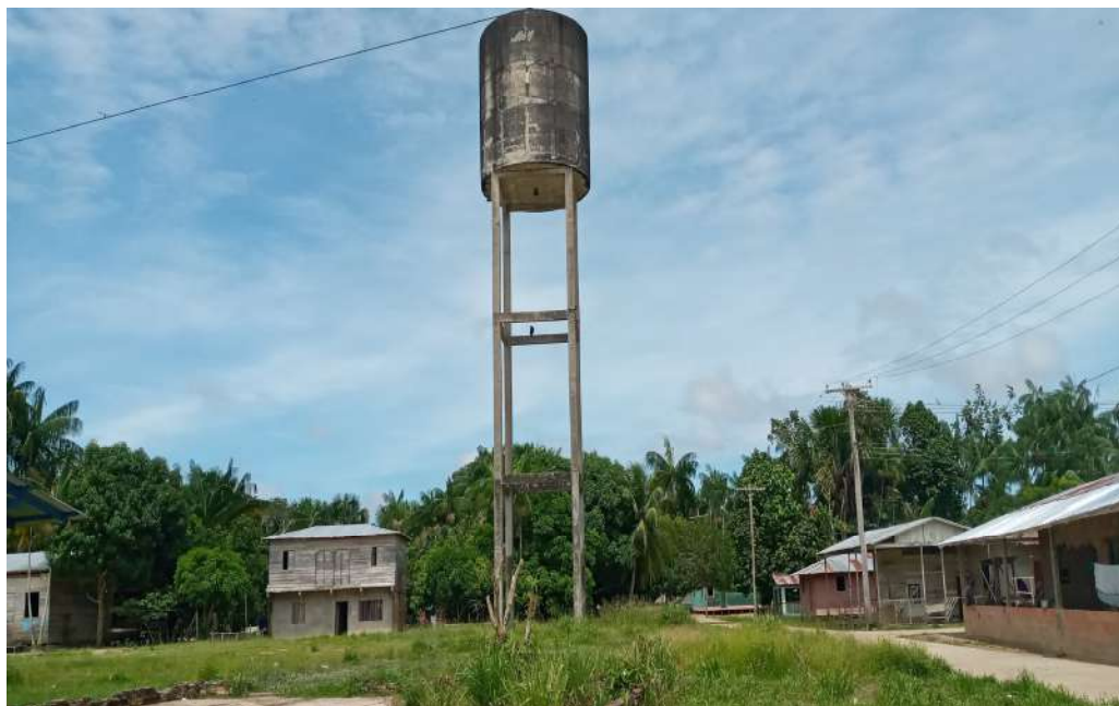
Foto 03 – Reservatório Elevado existente – RE de 50m 3 a ser retirado (demolido) do local.
