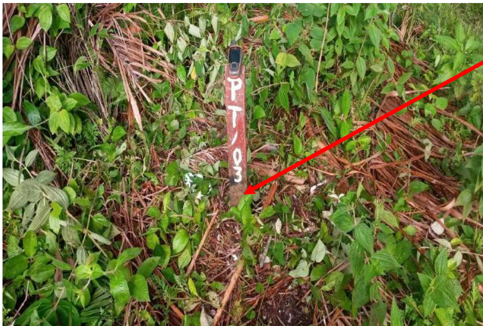
Foto 08 – A seta mostra a estaca do Local (tipo Ponto) escolhido p/a Construção do Poço nº 03 - SAA da Comunidade Campo Alegre - SPO - AM.
