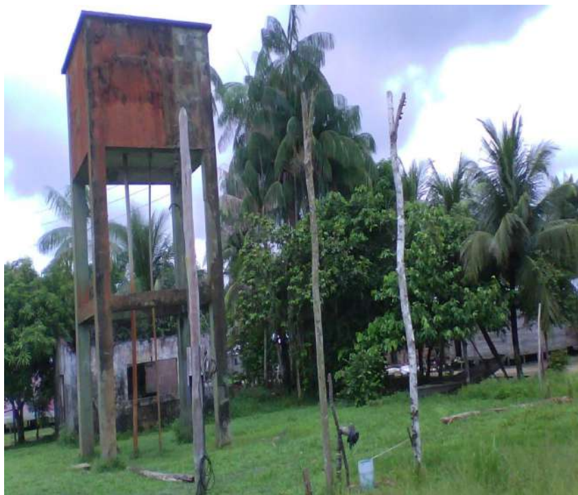
Foto 01 – Reservatório Elevado existente – RE de 20m³ a ser retirado (demolido) do local.
