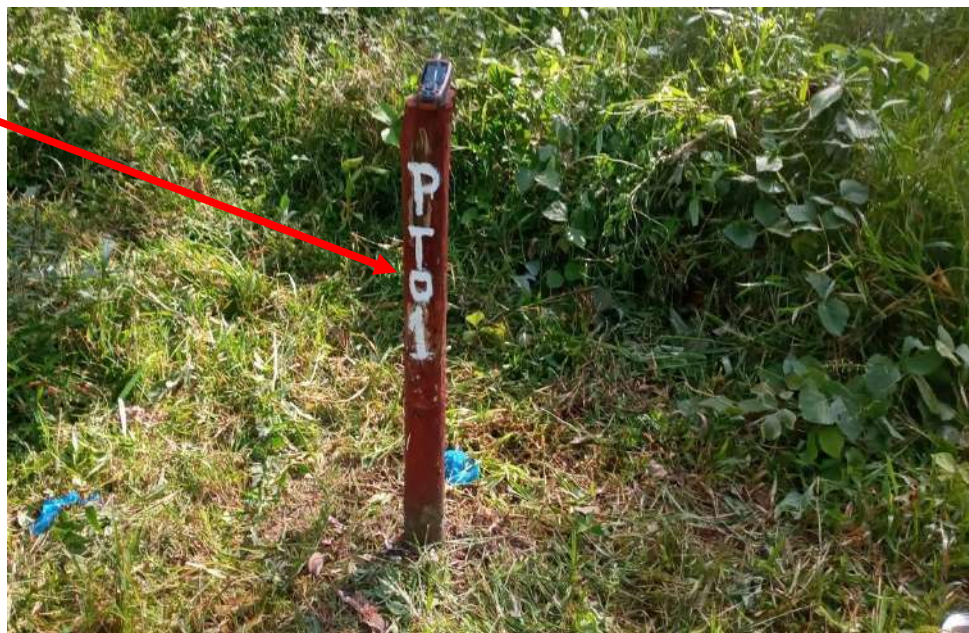
Foto 05 – A seta indica o piquete (a estaca) do Local (tipo Ponto) p/a Construção do Poço nº 01 - SAA da Comunidade Campo Alegre - SPO - AM.
