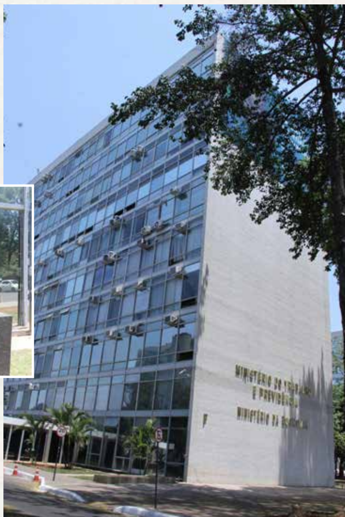
Edifício sede do Ministério da Previdência Social na Esplanada dos Ministérios, em Brasília
