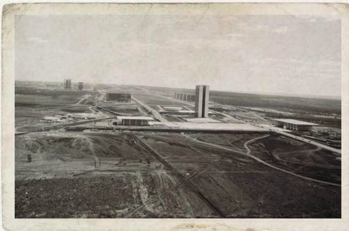
Construção de Brasília
