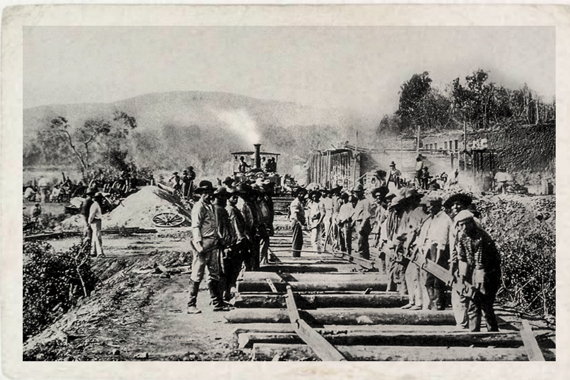
Construção da Estrada de Ferro Santos-Jundiaí
