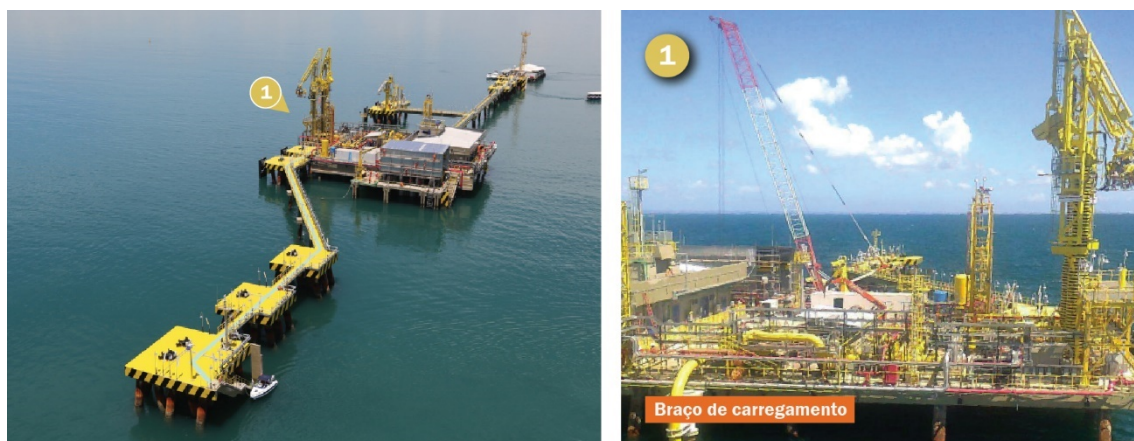
Figura 74 – Braços de carregamento do TRBA
