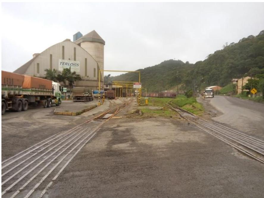
Figura 53 – AMV à esquerda (movimentação interna) e Terlogs; AMV à direita (movimentação no pátio – ALL e acesso à Bunge)
