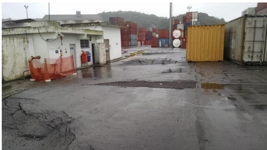
Figura 37 – Presença de deformidades no pavimento no TESC
