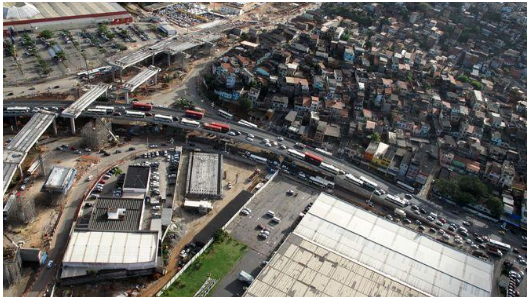
Figura 45. Via Expressa BR-324, acesso ao Porto de Salvador
