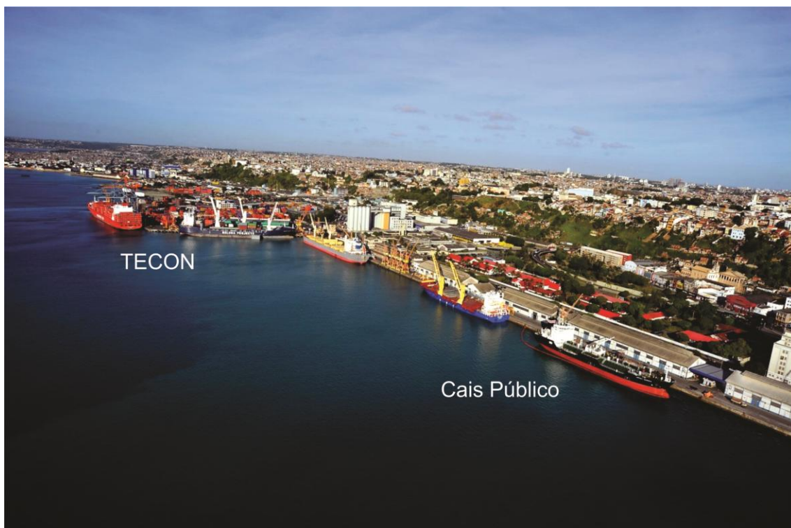
Figura 13. Vista aérea do cais do Porto de Salvador
