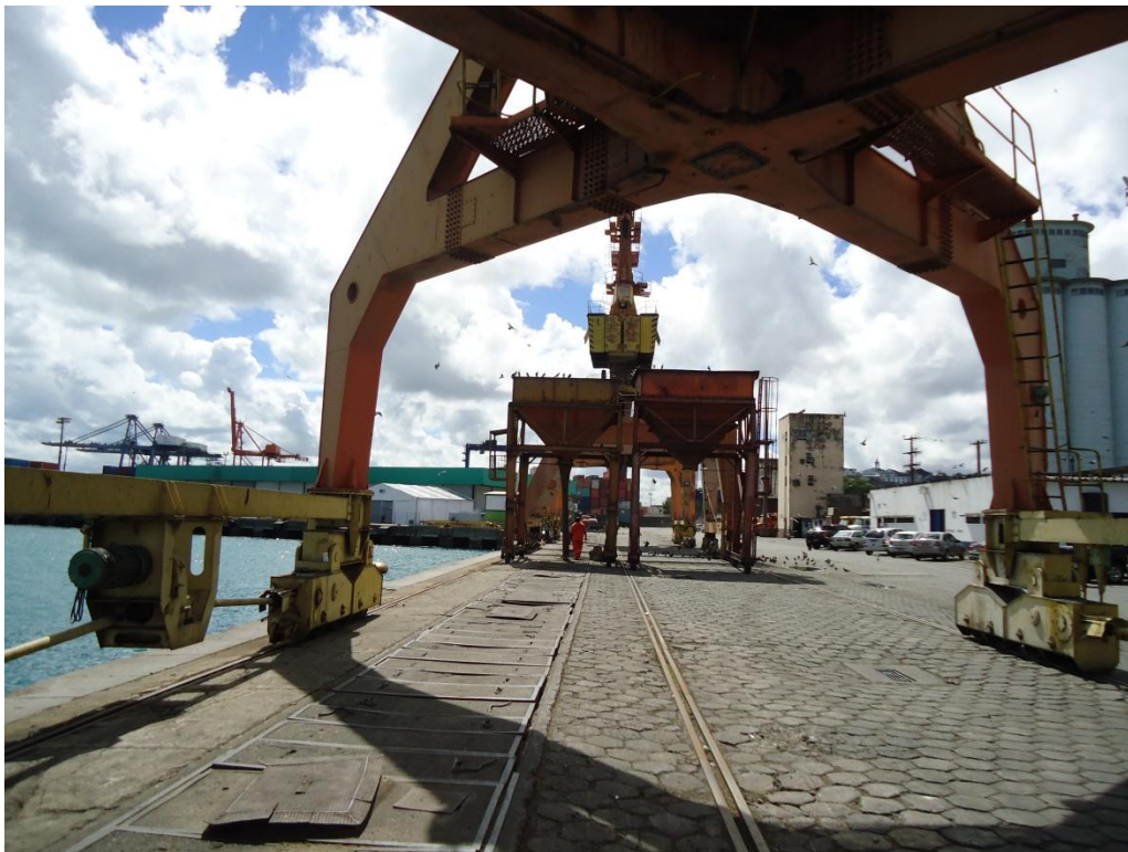
Figura 16. Moega Transportadora para Trigo – Cais Público
