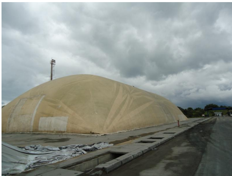
Figura 18. Armazém provisório de granéis sólidos – Porto de Aratu
