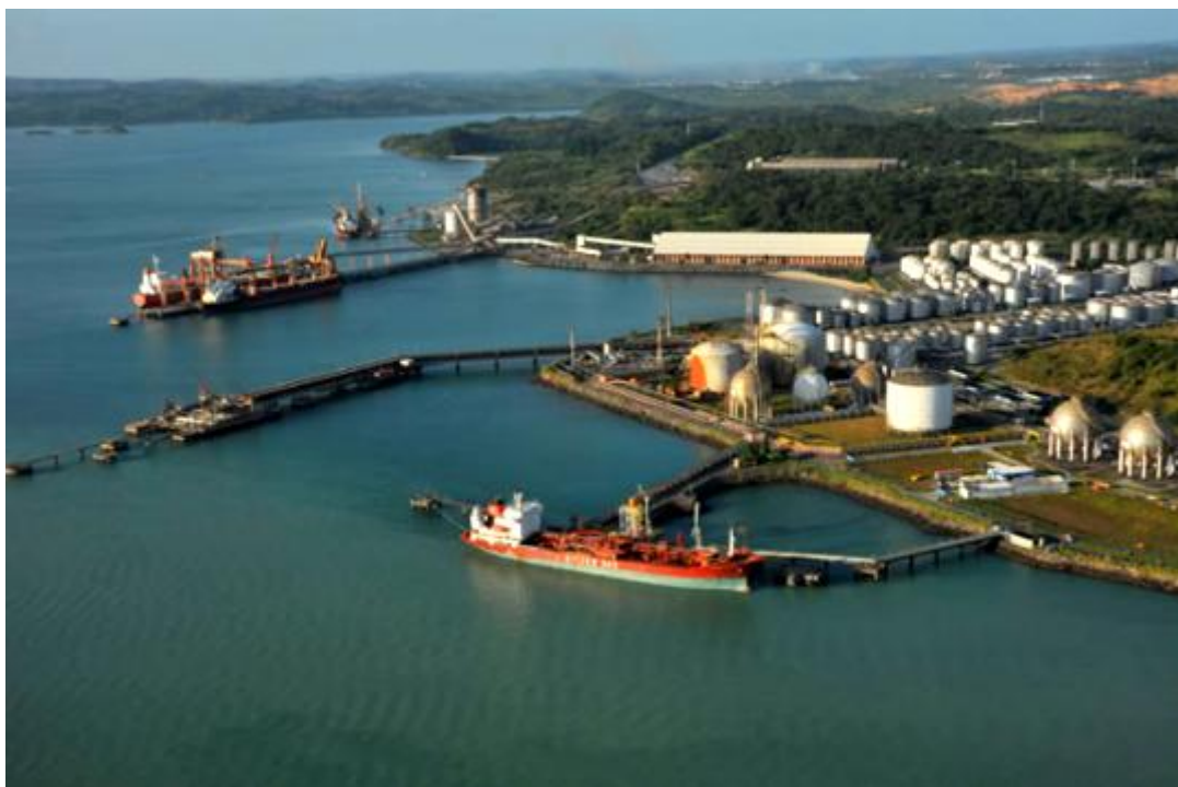
Figura 24. TPG – Vista área – Porto de Aratu
