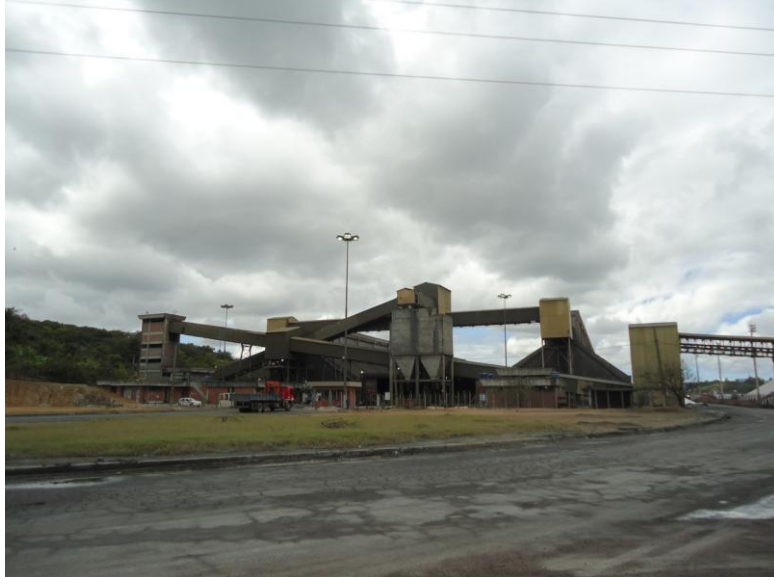
Figura 19. Estrutura de armazém do TGS – Porto de Aratu
