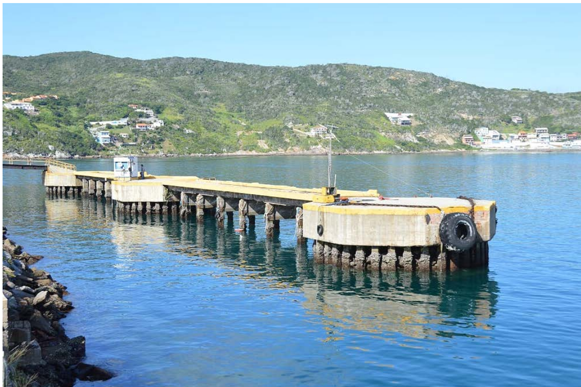
Figura 9 – Infraestrutura dos dolphins Duques d’Alba do Porto do Forno Fonte: Imagem obtida durante a visita técnica
