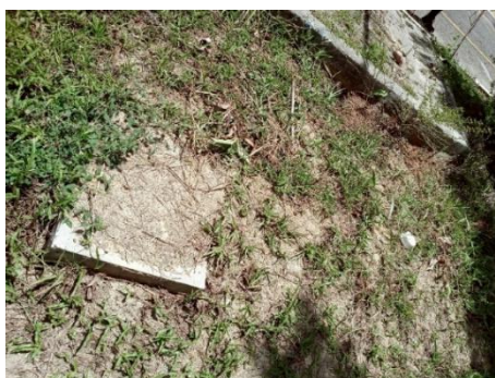
Figura 48 – Fotografia da estrutura externa (tampa de concreto e tubo branco) de uma das fossas do porto
