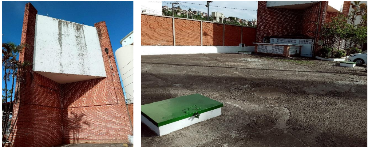
Figura 39 – Fotografia dos maiores reservatórios (um superior e dois enterrados) para acumulação de água no Porto Organizado de Salvador
