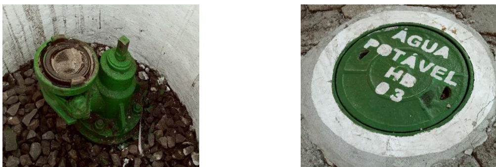
Figura 40 – Fotografia do ponto para fornecimento de água aos navios no Porto Organizado de Salvador
