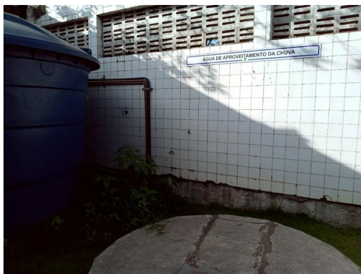
Figura 42– Fotografia da estrutura de armazenagem de água pluvial para fins de reuso
