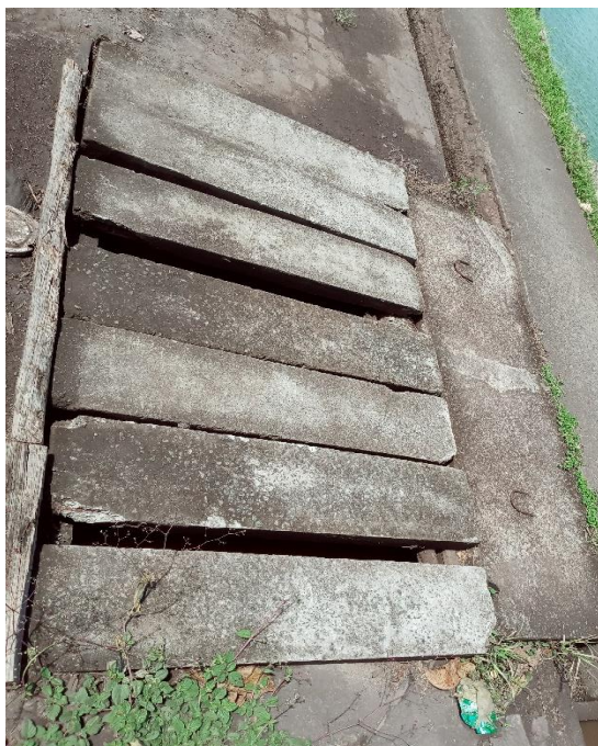
Figura 41 - Fotografia da canaleta de drenagem e caixa de sedimentação/decantação de sólidos
