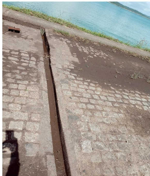
Figura 41 - Fotografia da canaleta de drenagem e caixa de sedimentação/decantação de sólidos
