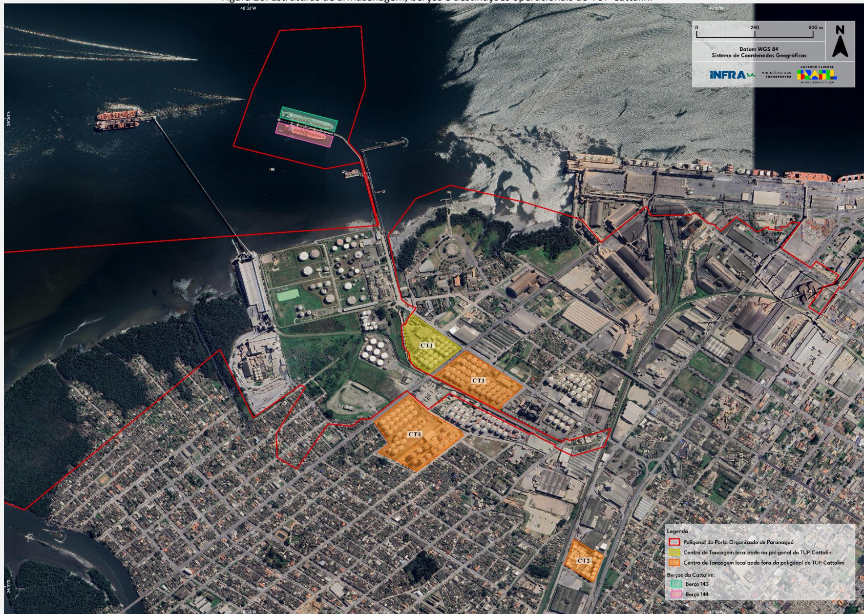
Figura 20: Estruturas de armazenagem, berços e destinações operacionais do TUP Cattalini
