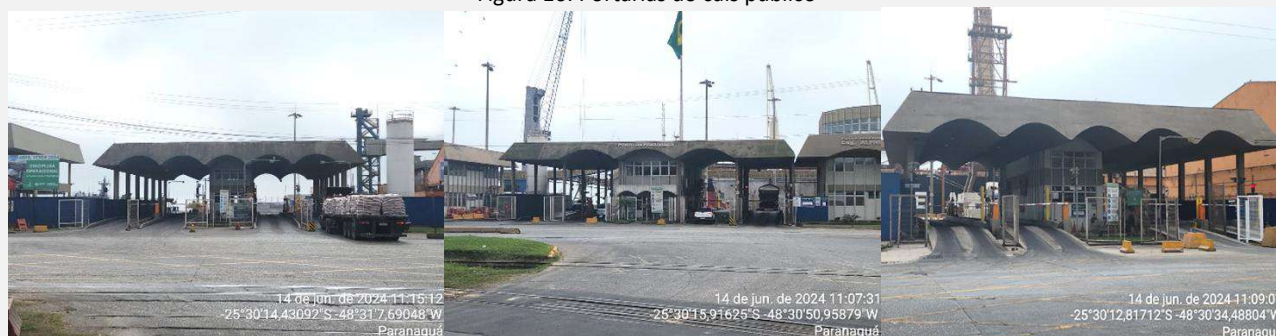
Figura 16: Portarias do cais público
