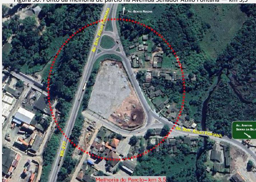
Figura 30: Ponto da melhoria de parco na Avenida Senador Atílio Fontana — km 3,5
