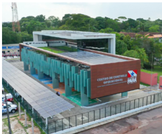
FIGURA 17 – Centro de Controle Operacional (CCO)
