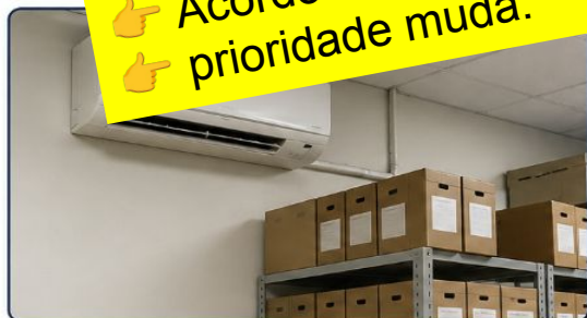
AR CONDICIONADO – ARQUIVO MORTO
