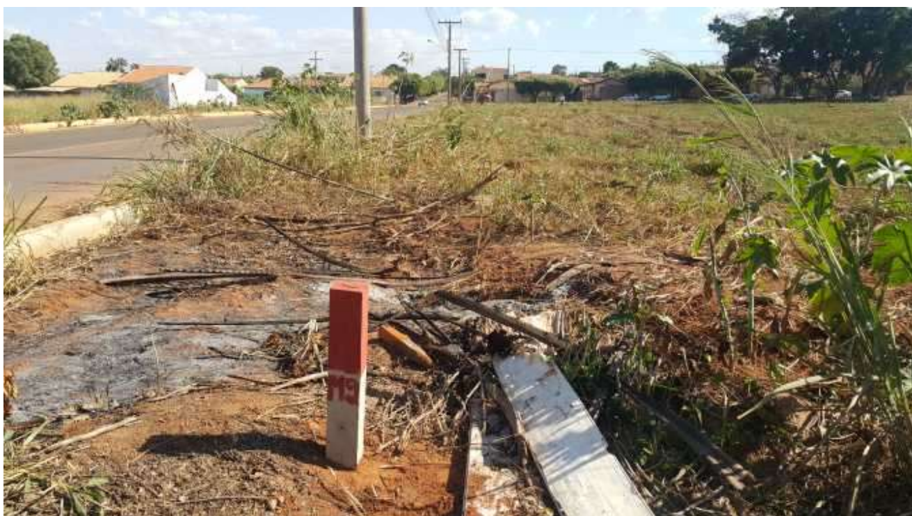
Fig.2-Vista do Marco 2 - Rua Piauí x Rua São Judas Tadeu.
