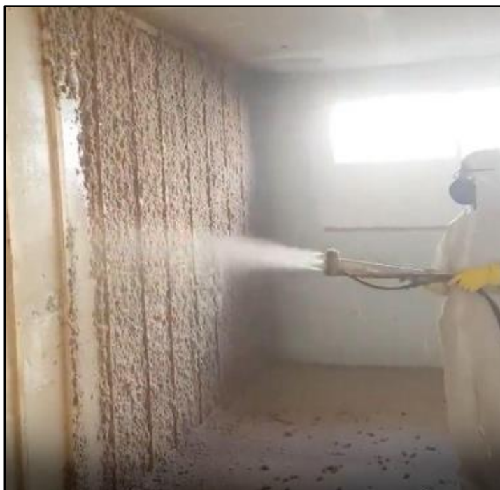
Figura 5 - Exemplo de aplicação de jateamento de fibra de celulose.
