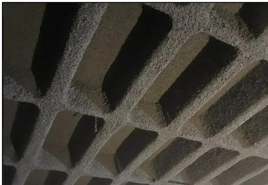
Figura 4 - Exemplo de laje nervurada com aplicação de jateamento de fibra em celulose.
