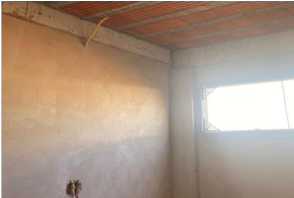
Figura 13: Eletrodutos já instalados in loco
