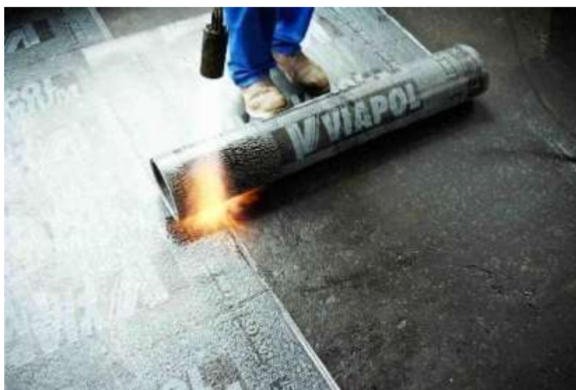
Figura 01: Impermeabilização com manta asfáltica
