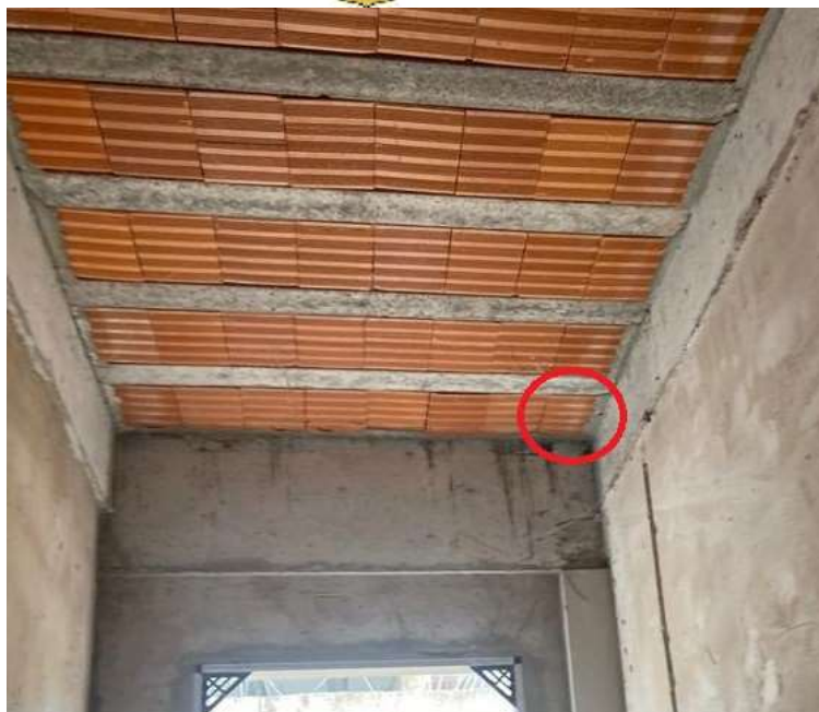
Figura 09: Furos na laje
