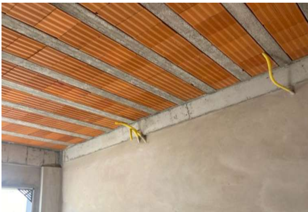
Figura 12: Eletrodutos já instalados in loco
