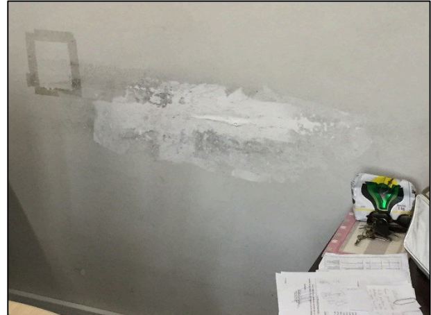
Figura 19 – Note-se a pintura das paredes.
