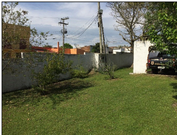
Figura 40 – Entrada de energia da delegacia. Possível local de instalação do gerador.
