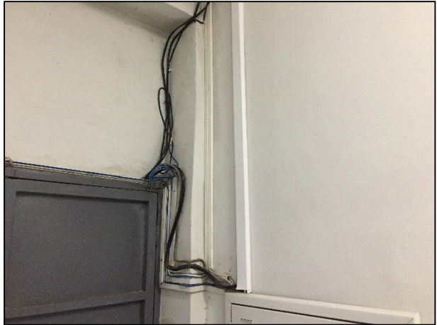
Figura 31 – Ampliações sucessivas da rede elétrica existente.
