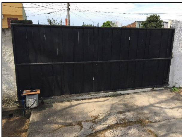
Figura 41 – Vista do atual portão de entrada de viaturas.
