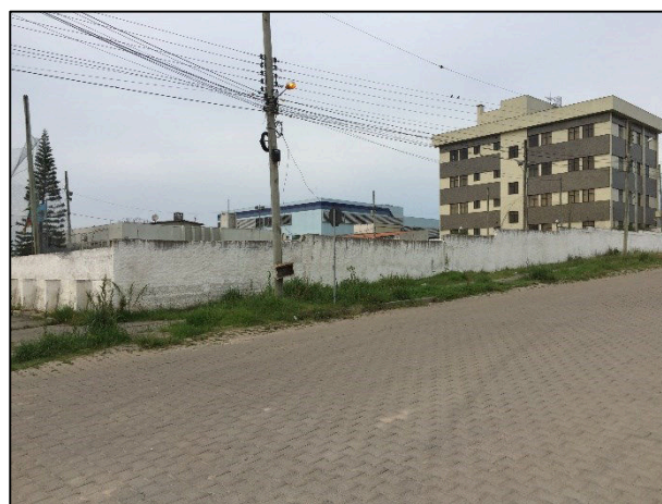
Figura 13 – Vista externa do mesmo muro, pela Rua Marechal Floriano.
