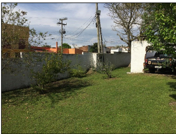
Figura 34 – Vista posterior da cobertura de garagem existente.
