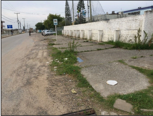
Figura 2 – Frente da delegacia, Rua Júlio de Castilhos (esquina com a Rua Mal. Floriano).
