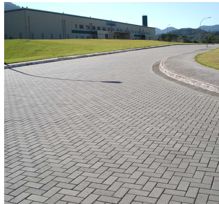
Ref.: Pavimento Intertravado Retangular – PAVER, 10,5 x 21 x 6cm – Linha Holland. Cor Cinza Natural.
