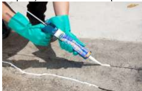
Aplicação do Selante Monopol PU
