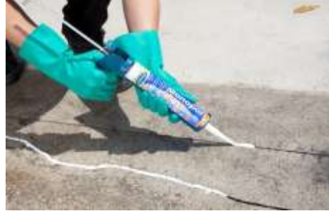
Aplicação do Selante Monopol PU
