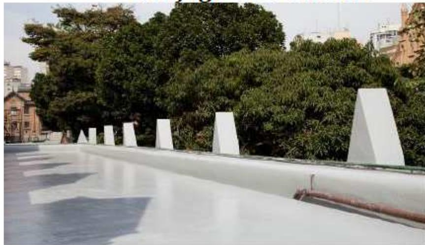
O sistema de impermeabilização com membrana de poliuretano consiste na aplicação de três camadas principais, são elas: camada base, camada intermediária e topcoat.
