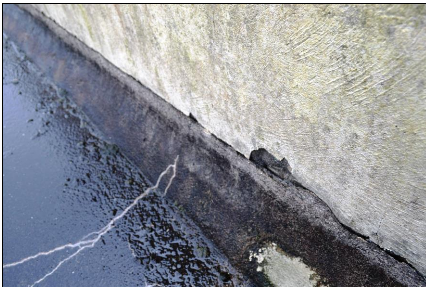
Fotografia 8 - Rachadura horizontal
