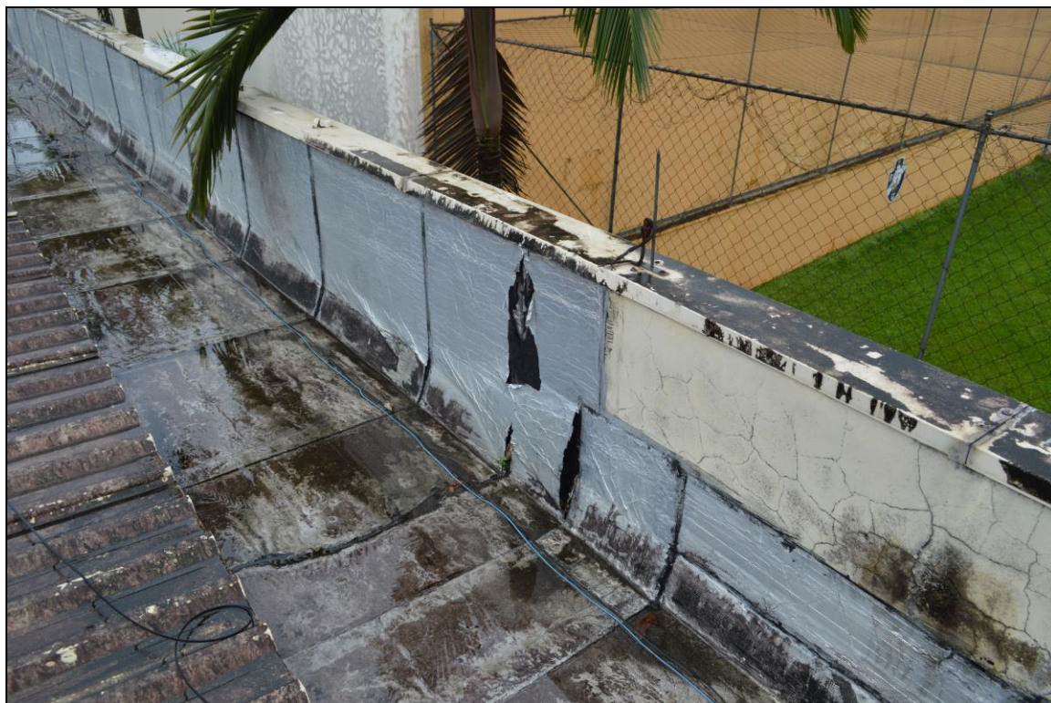
Fotografia 5 - Cordoalhas faltantes na rede de para raios
