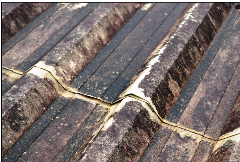
Fotografia 12 - Detalhe da fresta e do trespasse
