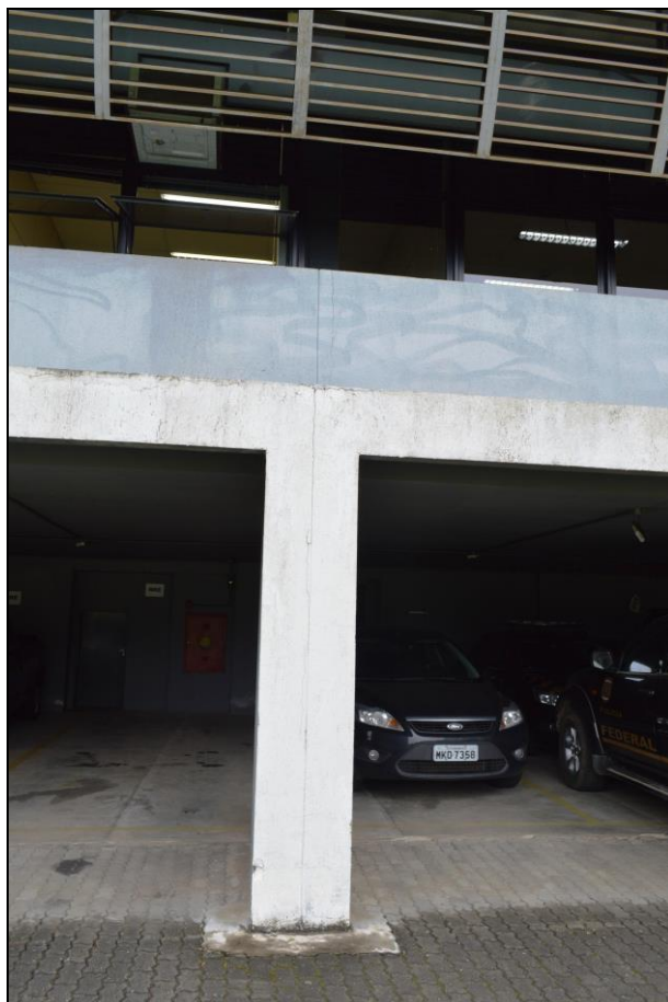
Fotografia 6 - Junta de dilatação vertical
