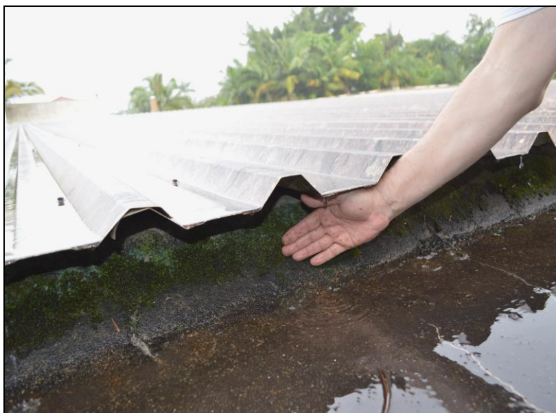
Fotografia 10 - Detalhe da altura da calha no beiral da telha
