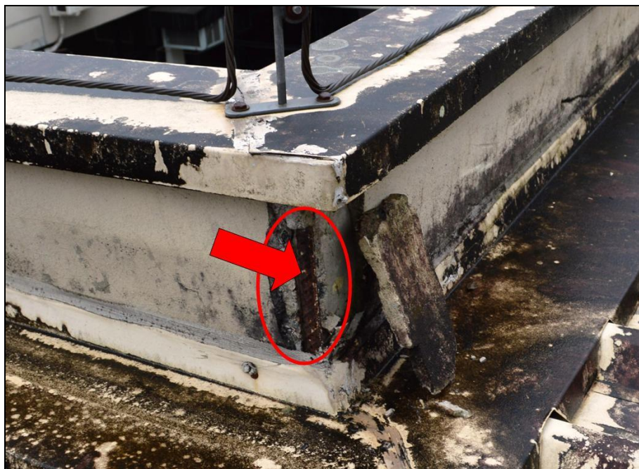
Fotografia 13 - Corrosão de armadura sinalizada
