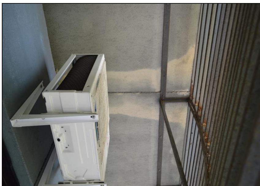
Fotografia 7 - Infiltração pela junta de dilatação
