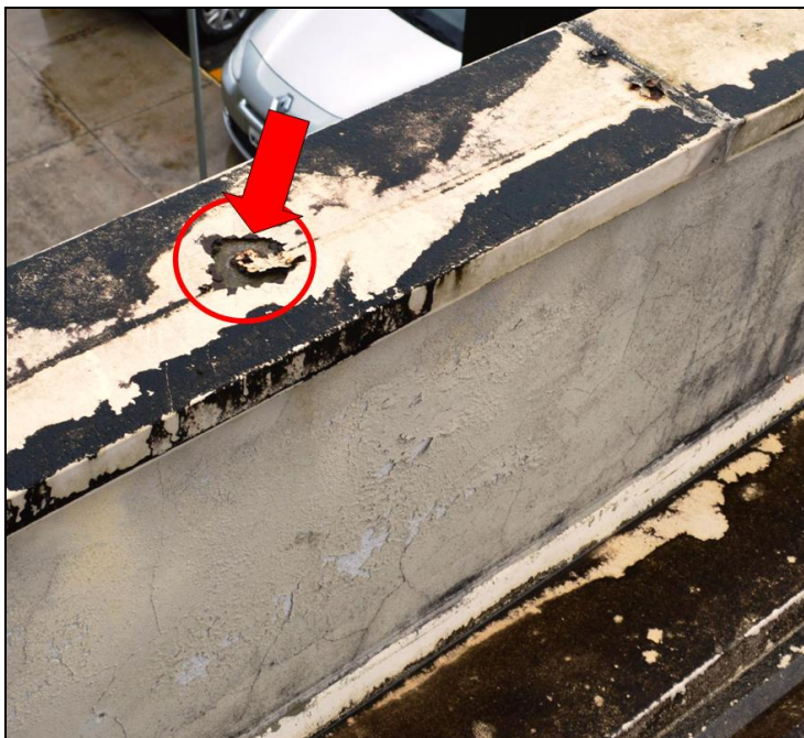
Fotografia 4 - Rufo metálico corroído
