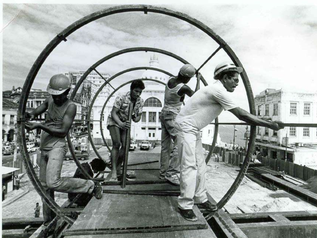
Figura 26 – Fotografia da construção do duto de ar condicionado na cobertura do Palácio Tomé de Souza, realizada em 1986 (Fonte: Arquivo Histórico Municipal)
