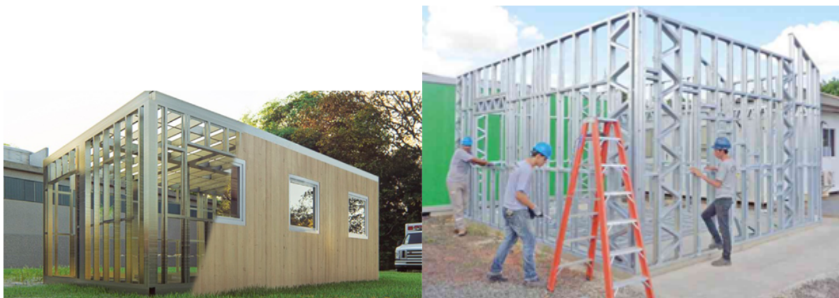
Figura 5: Sistemas painelizados sendo instalados.
