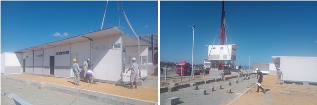
Figura 4: Sistemas modulares sendo instalados.
